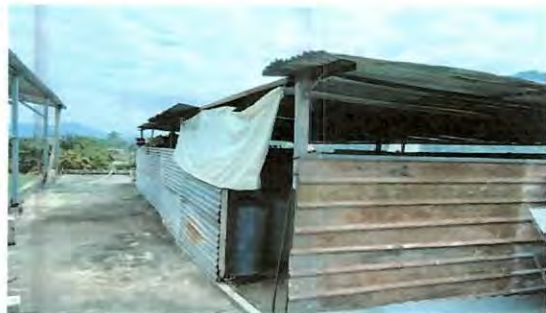
Foto1: Remozamiento de la bodega con la construcción de dos pórticos con tres haldas de block y estructura de metal y techo de lámina troquelada.
