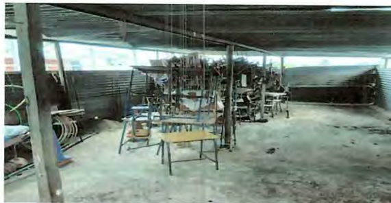
Foto 2: Este es el interior de la bodega que será reamozada con la construcción de los pórticos
